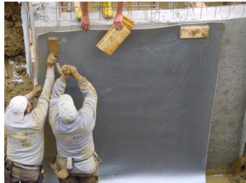
2. Einlegen der SilverSeal Quellmitteldichtungsbahn in die Schalung. Durch den Verbund zum Frischbeton haftet SilverSeal am Wandbeton.
