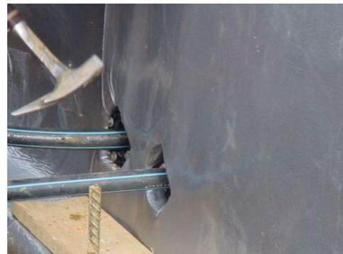
Jede Durchdringung stellt eine potentielle Schwachstelle dar und muss daher immer individuell und objektbezogen geplant und abgedichtet werden.
