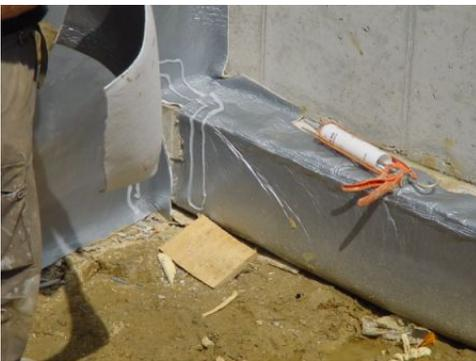
**Überlappung:** Die Überlappungen sollten 5-10cm betragen und sind immer mechanisch zu fixieren. Der Anpressdruck sollte mindesten 150 kg/m<sup>2</sup> betragen.
