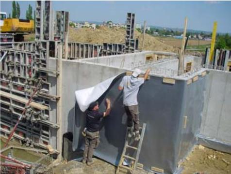
Horizontale Überlappungen werden durch zusätzliches Verkleben mit CEM805 Kleber gesichert. Vertikale Überlappungen werden mit CEM805 verklebt.
