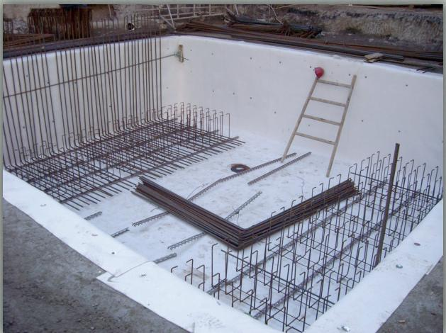
**CEMproof® SilverSeal** wurde an der MPA Braunschweig geprüft! Mit CEM 805 verklebt, ist die Stoßverklebung bis 2,5 bar Wasserdruk dicht.
