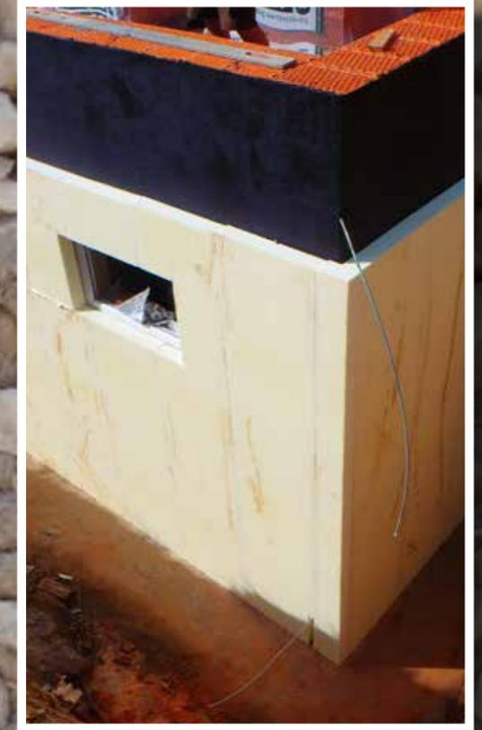
Die XPS-Platten mit Schaum oder Baudichtkleber befestigen.
