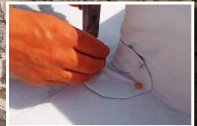
Oder einen fertigen Mauerkragen verwenden.
