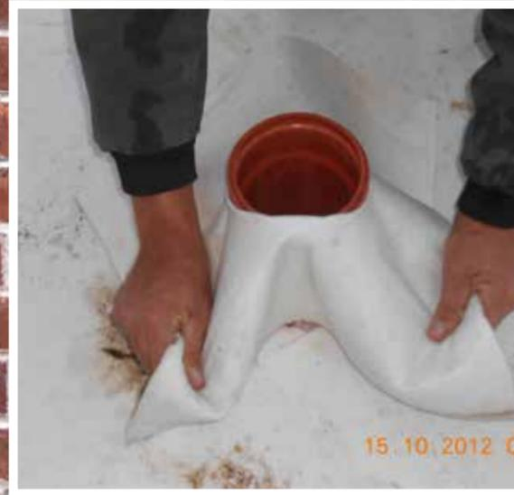
Bei den Rohrdurchführungen muss ein zusätzliches Feld zugeschnitten werden, mit einem Maß von 50 x 50 cm.
