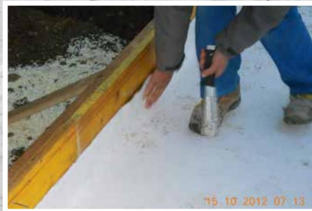
Bodenplattenabdichtung mit selbstdichtendem **Silver Seal**. Die Verarbeitung richtet sich nach Vorgaben des Herstellers und Stand der Technik lt. Din. Deutschland und ÖNorm Österreich.
