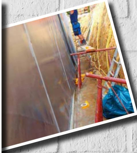
Überlappungen sowie Eckausbildungen, Mauerdurchführungen und entstandene Beschädigungen mit einem CEM 805-Kleber oder einem Klebeband verkleben.
