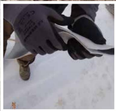
Einen 20 cm breiten Streifen herunter schneiden, mit der Silberseite zusammenklappen und um das Rohr wickeln.
