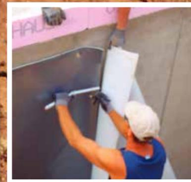
Auf die 12 cm-Überlappung achten. Wird zum Beispiel mit einem Schussapparat angeschossen oder mit einem Sprühkleber vollflächig aufgeklebt.
