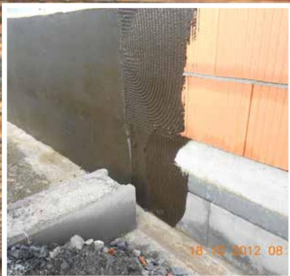
Die Drunterleisten sollten verkehrt eingebaut werden. Die Verlegerichtung soll immer entgegengesetzt der Betonrichtung sein, um ein Unterlaufen der Folie während der Betonierarbeiten zu verhindern.
