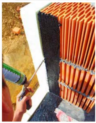
*Silver Seal* sollte max. 20 cm unter dem fertigen Niveau hochgezogen werden und der weitere Anschluss mind. 50 cm über dem fertigen Niveau.
