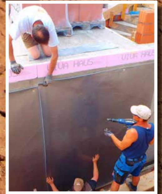
Außen- und Innenecke mit Baudichtkleber CEM 805 schließen.
